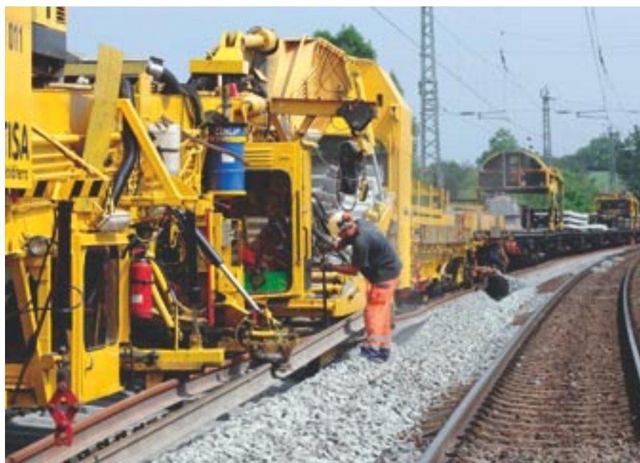
Bauarbeiten Mühlacker-Bruchsal, Investitionen in die Schieneninfrastruktur schaffen Arbeitsplätze Foto: DB AG/ Gustavo Alabiso
