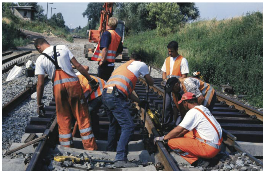
Vorausschauende und integrierte Planung ist für die Instandsetzung bei DB Netz die Strategie der Zukunft.
