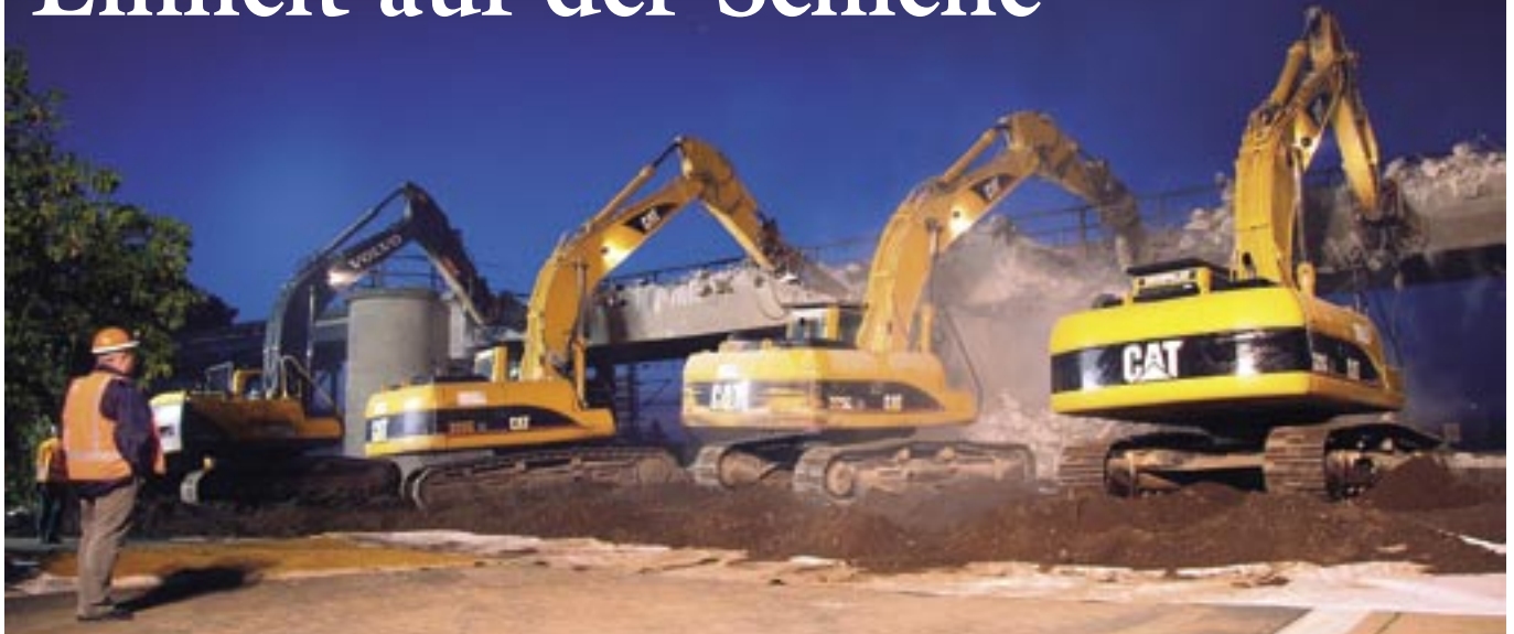
Bauarbeiten an der Nürnberger Ringbahn (VDE 8.1).
