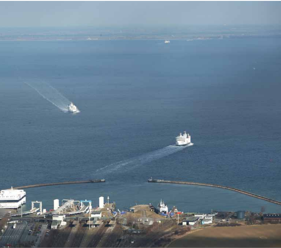
beträgt zwischen Puttgarden (im Vordergrund) und Rødby lediglich 17 Kilometer. Kurz vor den Bau eines Tunnels unter dem Fehmarnbelt. Alle Fotos/Grafiken: Fernern A/S
