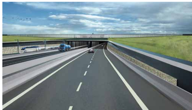
▲ Eine weitere Variante ist ein Tunnelbauwerk unter dem Meeresboden. In vier Röhren nebeneinander sollen nach Fertigstellung ab 2020 der Schienen- und der Straßenverkehr die Meerenge in nur knapp zehn Minuten überwinden können.
