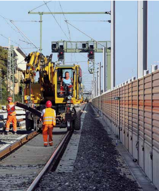
▲ Verschiedene Maßnahmen werden bereits umgesetzt, um die Lärmbelastung an den Schienenwegen zu reduzieren. Schallschutzwände sind die sichtbarsten Ergebnisse. Getestet wird derzeit auch der Einsatz von Schienenstegdämpfern, die die Schwingungen der Schienen
