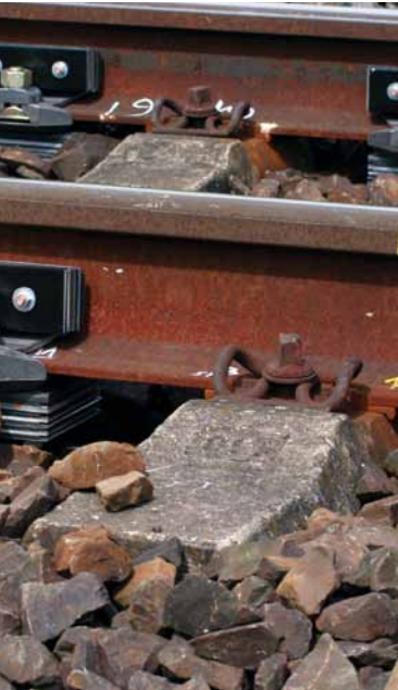
▲ bei der Überfahrt eines Zuges „schlucken“ und so die Geräuschentwicklung um bis zu 3 dB(A) reduzieren können. Regelmäßige Messungen stellen sicher, dass die Grenzwerte eingehalten werden. Fotos: DB AG/ Frank Kriestedt/ Hartmut Reiche
